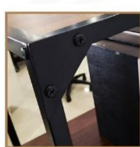
มีแผ่นเหล็กยึดมุมกับโครงถักเสริม
